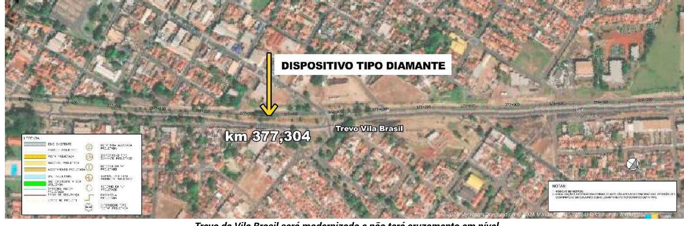
Trevo da Vila Brasil será modernizado e não terá cruzamento em nível
