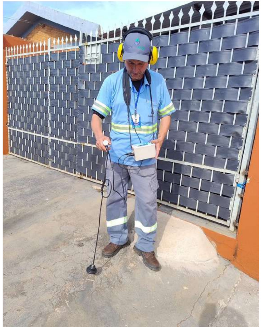
O trabalho foi executado por uma empresa parceira da concessionária, devidamente identificada
