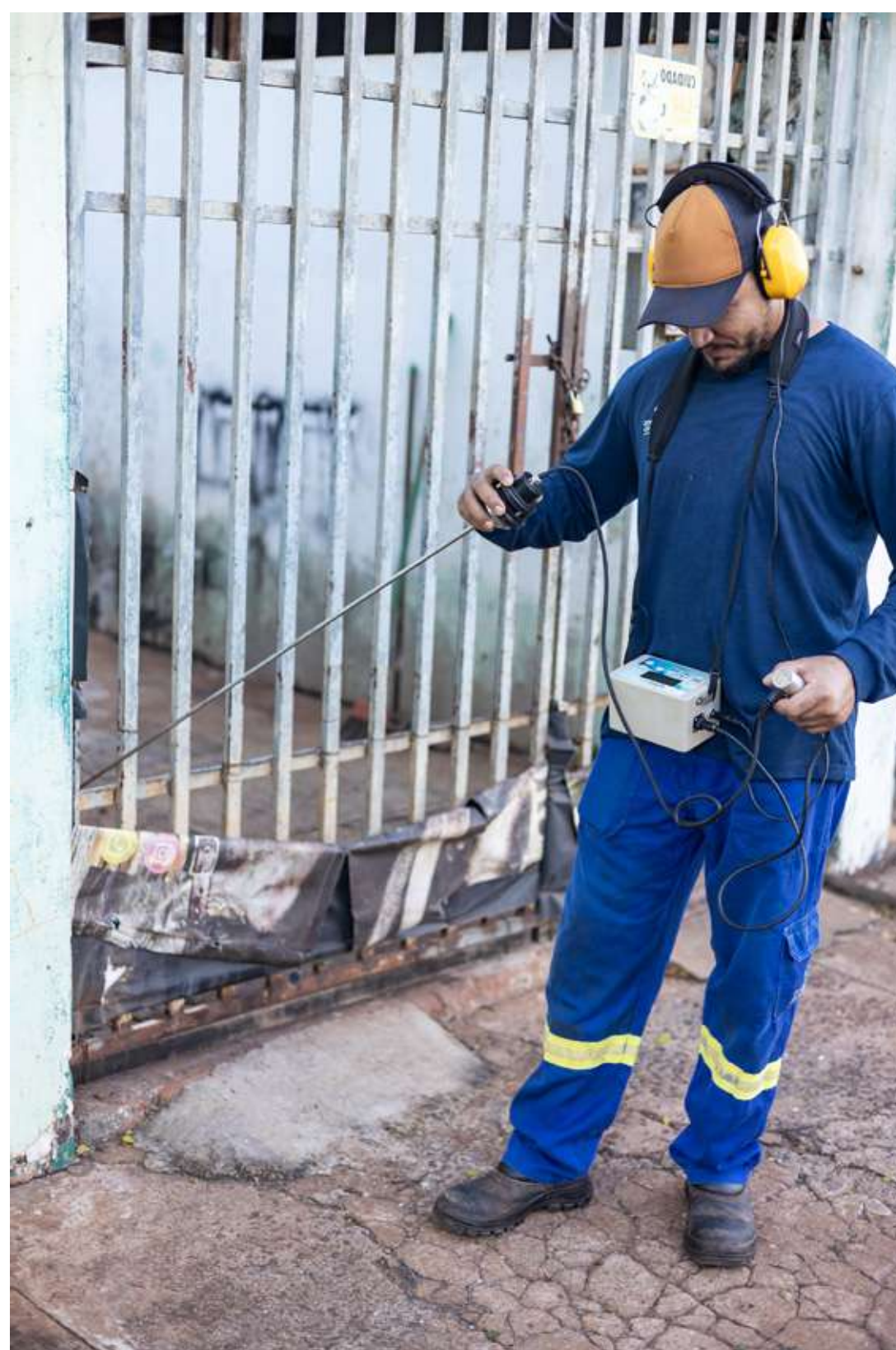
Trabalho de escuta em cavaletes ajuda a identificar vazamentos ocultos e aumentar a eficiência do abastecimento
