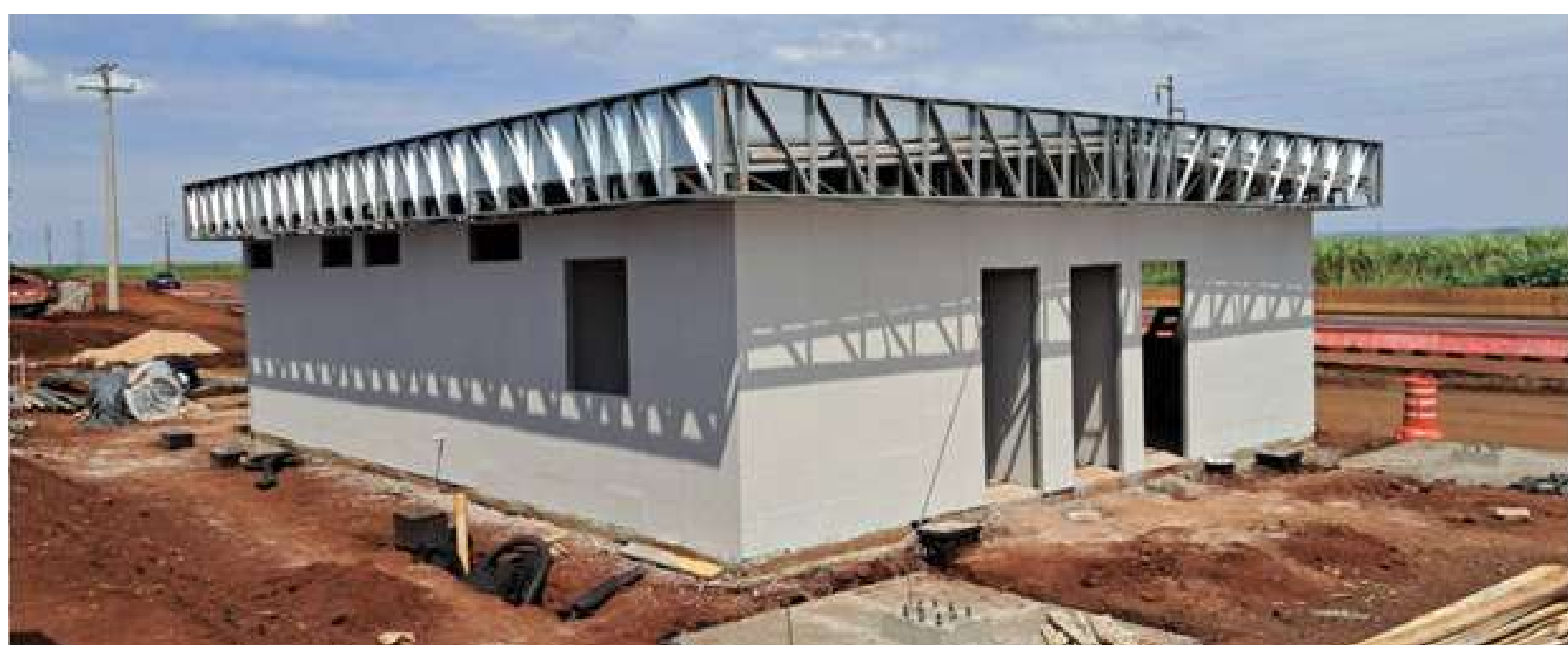
A base SAU6, no município de Chavantes estrutura funcional e confortável
