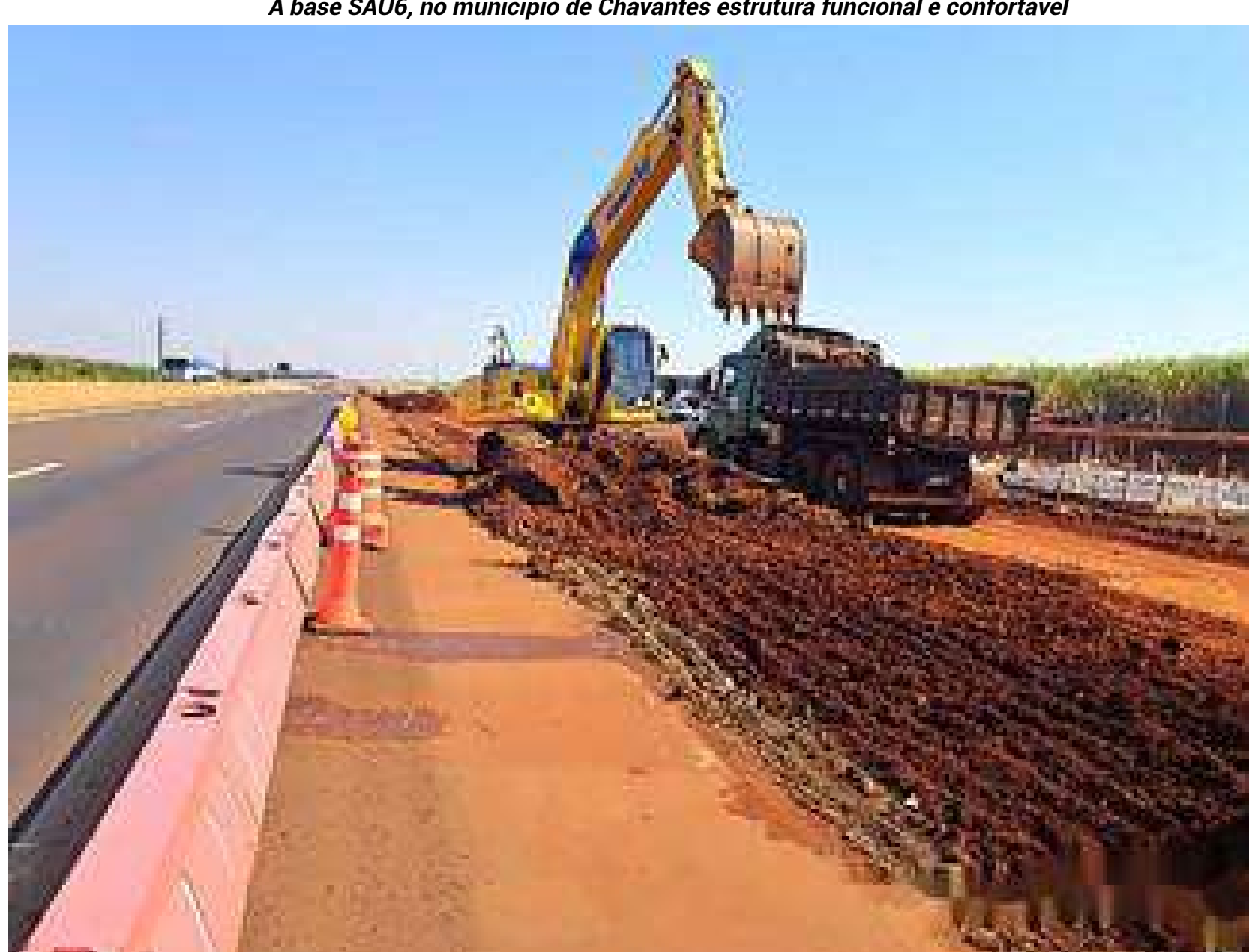
Maquinários trabalhando na construção
